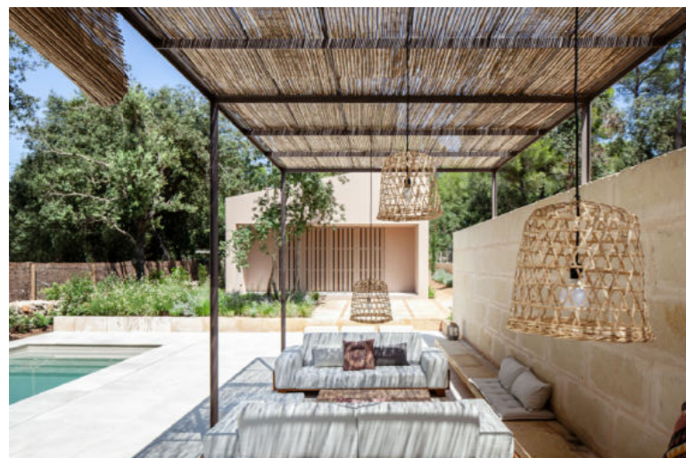
PÉRGOLA TIPO ESTRUCTURA METÁLICA LIGERA CUBIERTA DE CAÑIZO/VEGETAL
