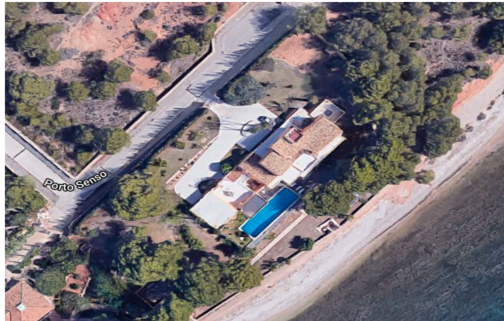
VISTA AEREA DE LA PARCELA Y VIVIENDA
